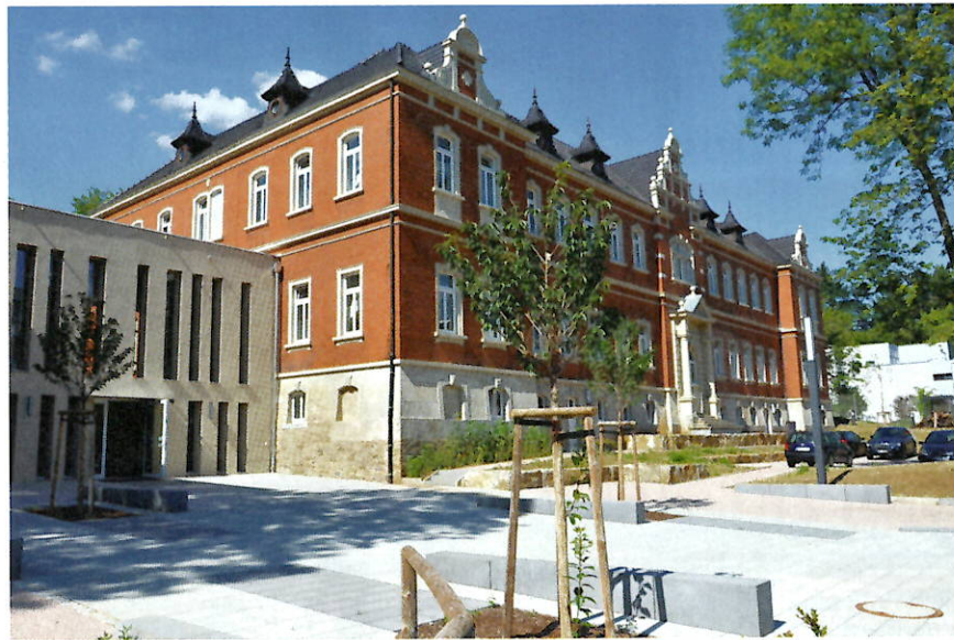
Die Carl-Sonnenschein-Schule nach der Sanierung, links der Zwischenbau.
